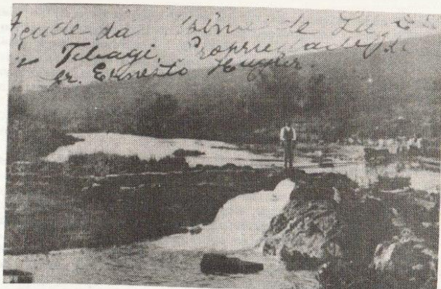
Foto da represa do arroio da Ingrata, vendo-se o seu construtor, Ernesto Kugler Sobrinho.
