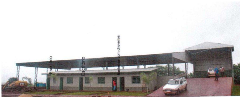
Figura 05: vista frontal da parte administrativa do barracão de triagem e aos fundos o local onde funcionará a operacionalização dos resíduos.
